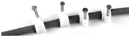
图 5-9 使用卡线钉对网线进行固定
