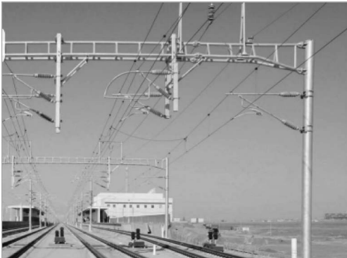
图 3-15 铁路供电系统接触网
