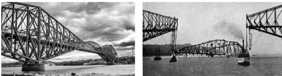
图 3-5 1907 年的魁北克大桥(左)和垮塌的魁北克大桥(右)
