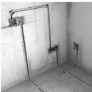
图 3-6 直接埋管布线施工图
