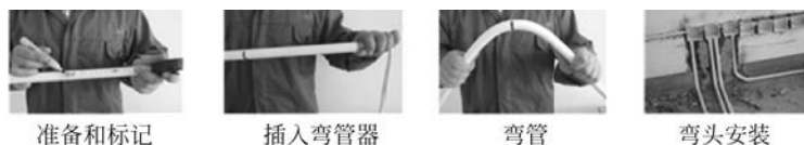
图 3-28 使用弯管器自制大拐弯的步骤
