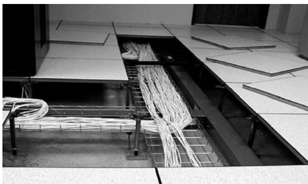
图 3-10 地面线槽布线施工图
